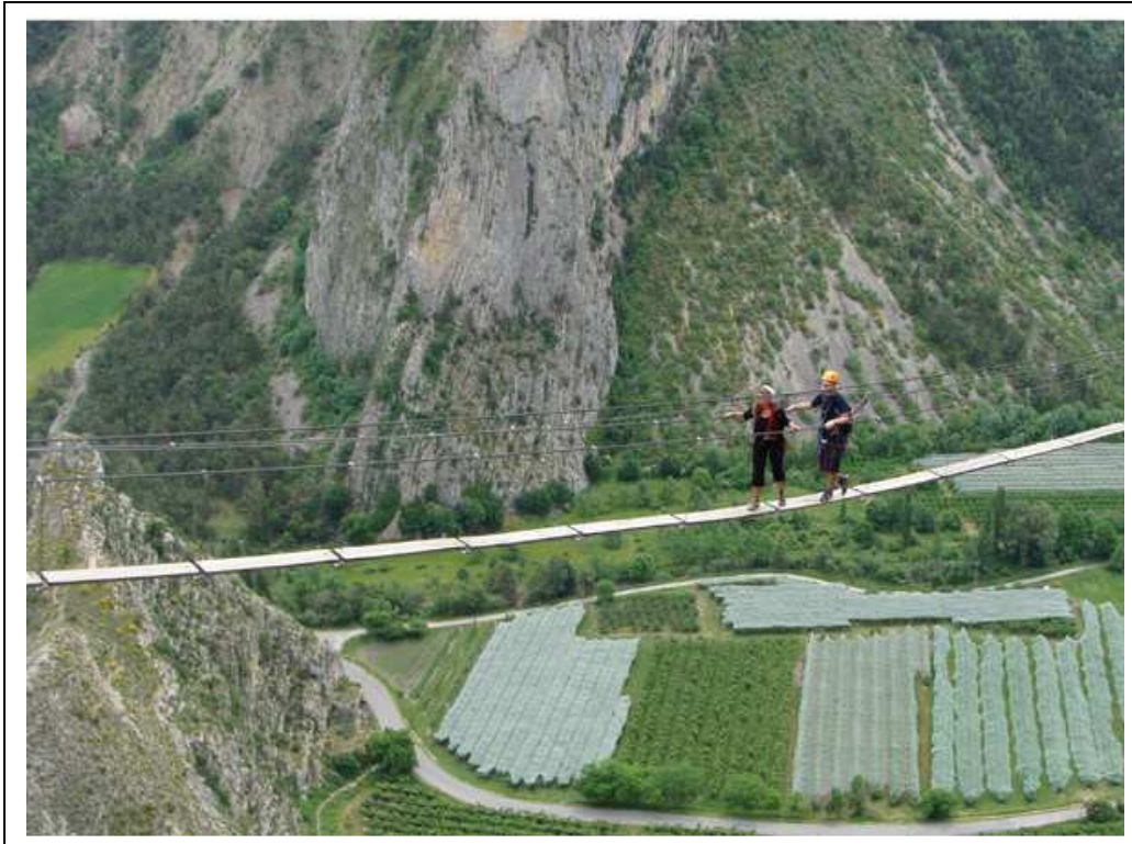
Violaine et thomas sur la grande passerelle de 58 m
